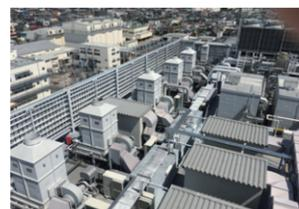
研究棟屋上スクラバー（排気処理装置）：大気汚染防止装置の一つで局所排気装置内から排出される有毒ガスを大気放出させるためにフィルターや中和液を用いて中和処理を行う設備
