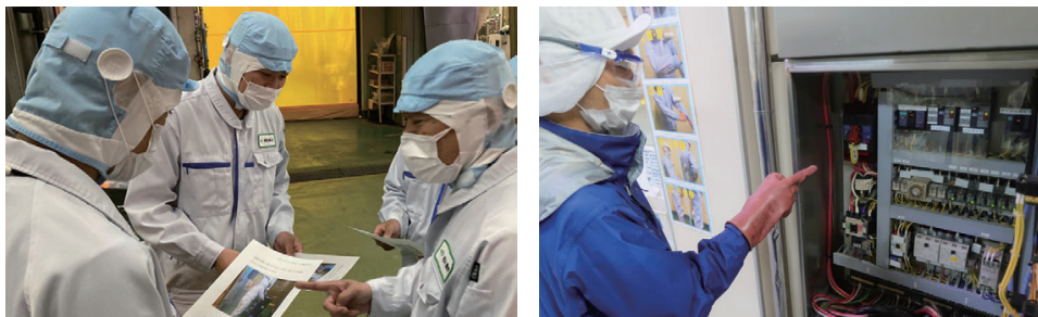
左/南海果工 危険予知訓練(KYT)の様子：危険の先取り手法を学び、製造現場で実践する 右/高砂フードプロダクツ 分電盤内のブレーカーの状態を指差し呼称で確認している様子
